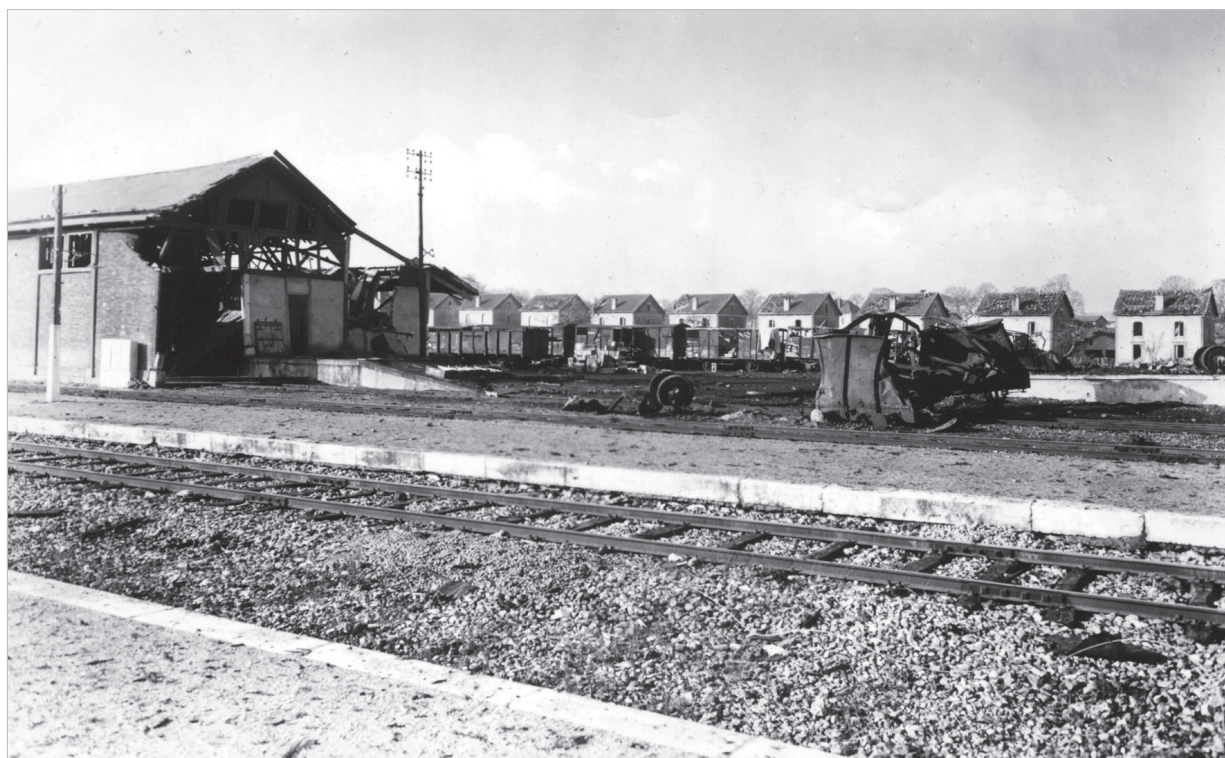
doc. 5 La voie ferrée, sur le site, n'est plus praticable
