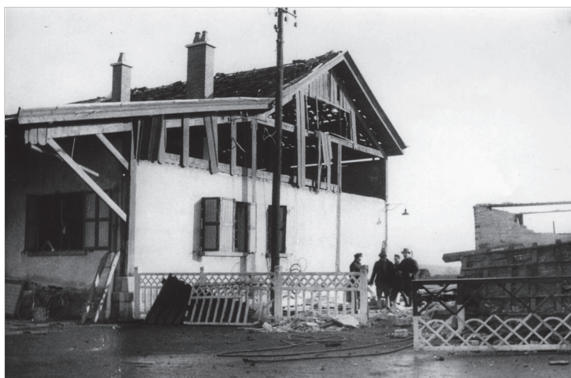
doc. 4 Plus que les habitations alentour, les bâtiments de la gare ont souffert des trois explosions successives
