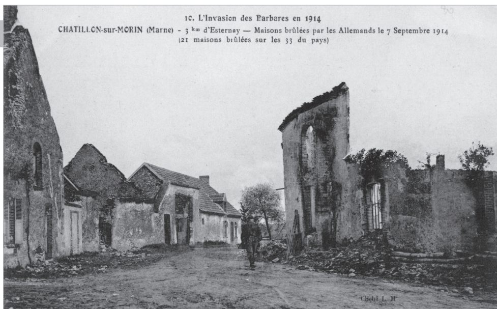
L'invasion des Barbares en 1914 CHATILLON-sur-MORIN (Marne) - 3km d'Esternay - Maisons brûlées par les Allemands le 7 Septembre 1914 (21 maisons brûlées sur les 33 du pays)
