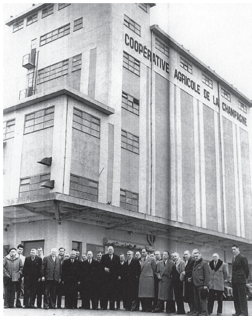
doc. 6 La Coopérative Agricole de la Champagne, les silos et les administrateurs
