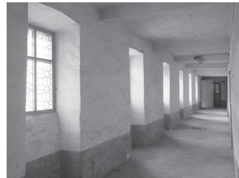
doc.5 Hôpital-hospice. Couloir du premier étage des salles des malades. Les fenêtres reçoivent la lumière du Nord. Nous avons dit autrefois que certaines portaient encore des vitraux sertis au plomb.
