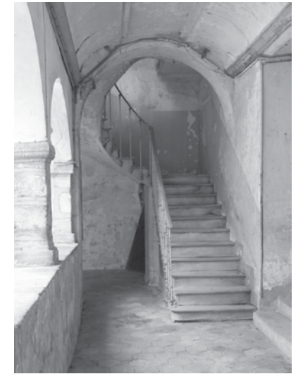
doc.6 Hôpital-hospice. Escalier donnant à l'étage, prenant naissance sous les allées couvertes du cloître, dans son coin Sud-Est. Il est à croire que les pensionnaires ont connu ce lieu tel que nous le voyons à l'image. Rien n'a changé depuis 1914. Il en est de même pour la photo précédente, et la suivante.
