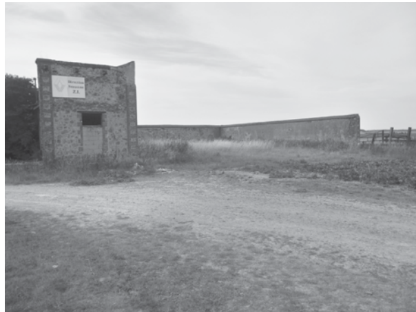
En 2014, les pans de murs restants indiquent l'emplacement du hangar du terrain d'atterrissage.
