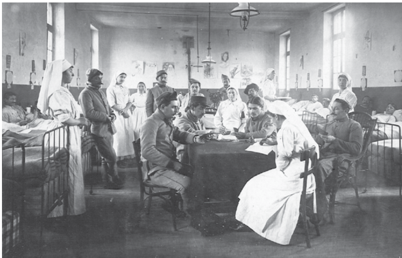
doc.11 Hôpital-collège. Une salle des pensionnaires. La grande allée offre un espace suffisant à l'installation de tables de jeux, et de travail pour les infirmières. On aura noté les quatre baies, hautes, mais dont les bases se situent au-delà du niveau des yeux d'un collégien assis. Il ne fallait pas que l'extérieur le perturbe dans sa concentration. Aujourd'hui les pédagogues privilégient l'option tout à fait contraire et d'immenses baies vitrées font le tour des salles de classe de la cité scolaire; de même que ces fenêtres de notre ancien collège (aujourd'hui médiathèque) partent quasiment du sol, par le rehaussement des planchers. Fonds Paillard-Lheureux.
